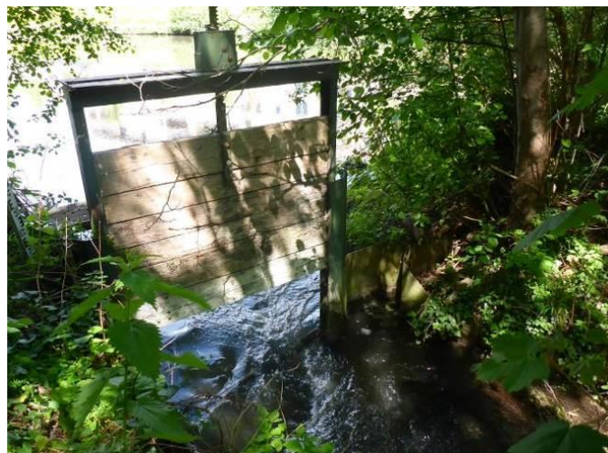
Vanne contrôlant le niveau d'eau dans le bassin, position ouverte (cadenassée)
