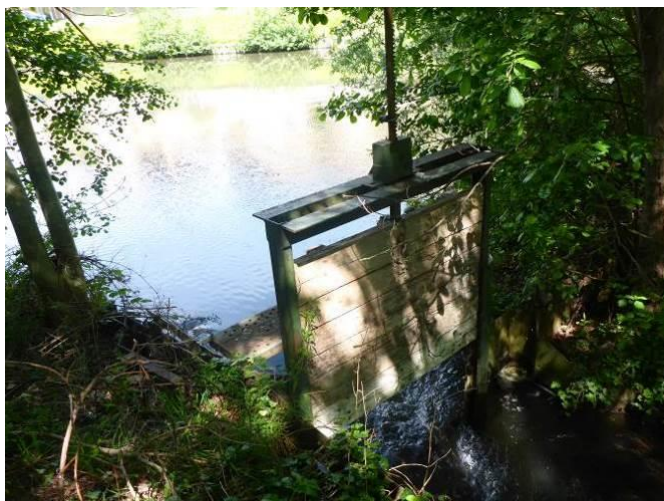
Vanne contrôlant le niveau d'eau dans le bassin, position ouverte (cadenassée)
