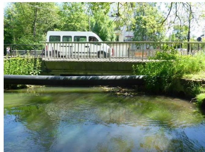
Pont de la rue Pasteur : très faible tirant d'air
