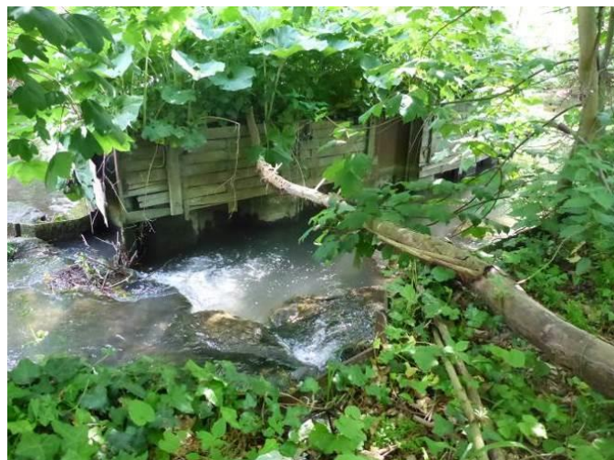
Vanne contrôlant le niveau d'eau dans le bassin, position ouverte (cadenassée)
