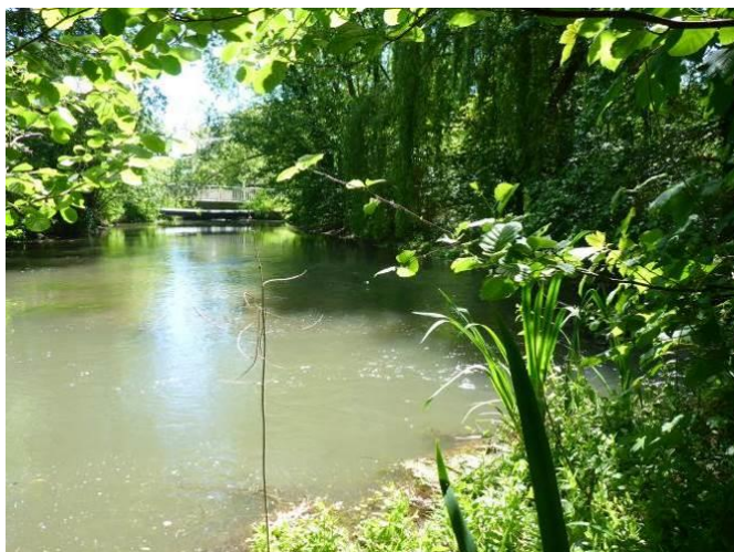
Pont de la rue Pasteur, en aval du bassin
