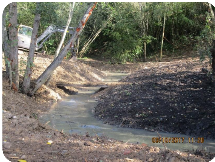
Talutage en pente douce, recharge granulométrique implantation d'une passerelle piétonne sur le 2 ème secteur
