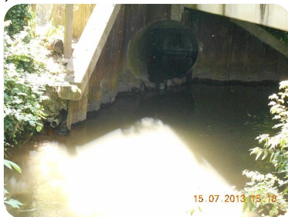
Rejet de collecteur rue des Pâtis
