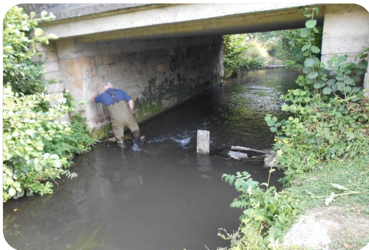
Barrage sauvage à Ableiges
