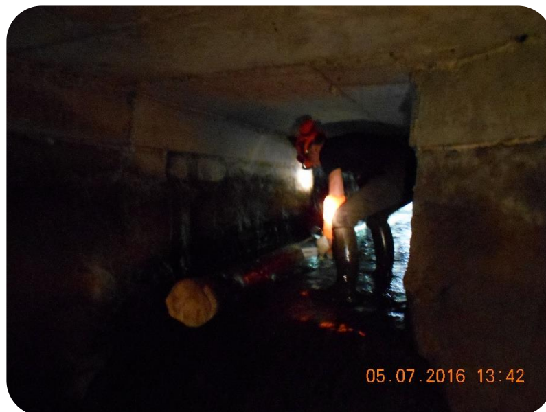
Intervention sous le moulin de Boissy
