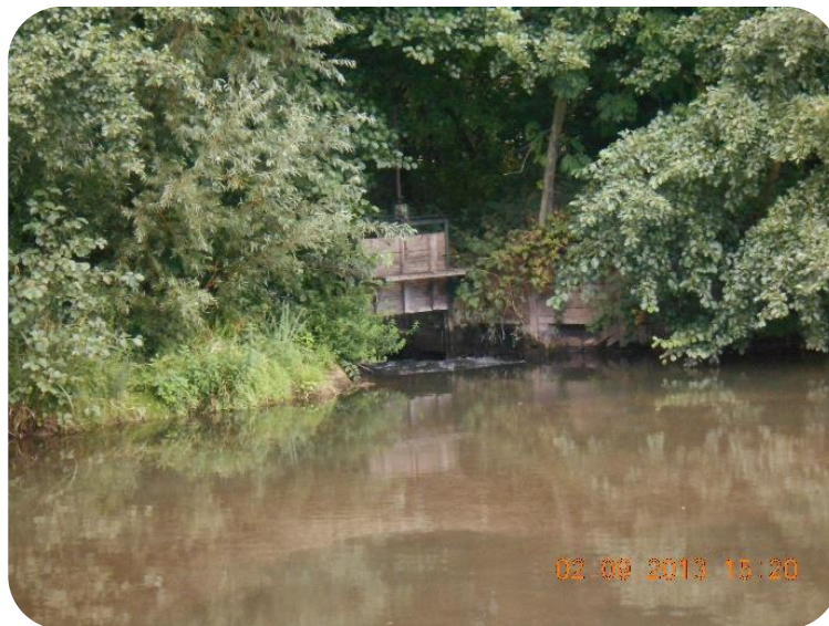
Vanne du bassin d'Osny
