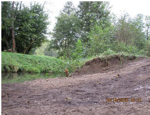
Talutage des berges et création de banquettes
