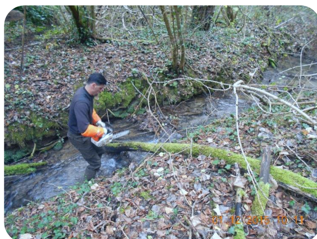
Entretien ru de la Gouline en amont des cressonnières
