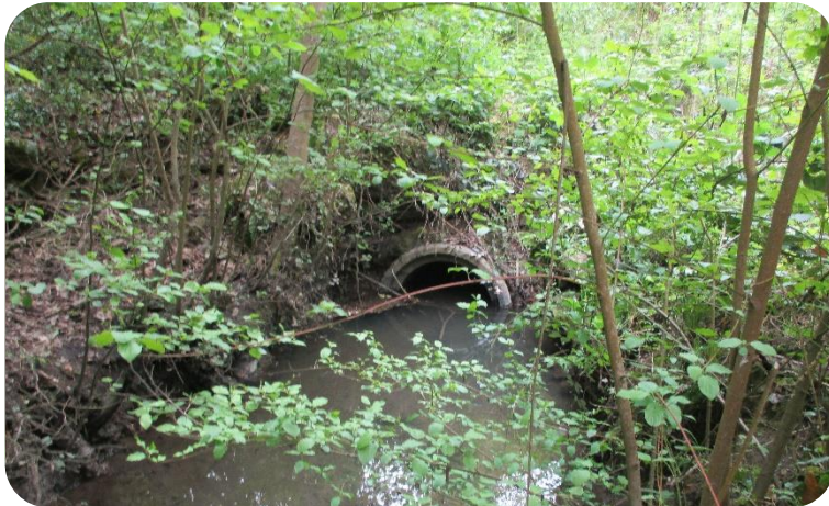
Avant travaux : 2 séries de busages mal calibré faisant obstacle à la continuité
