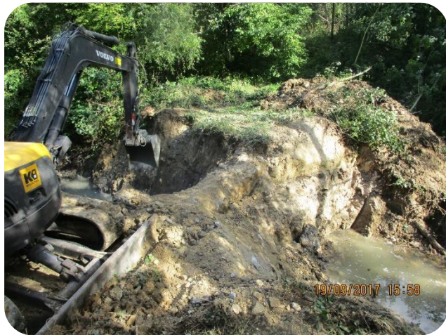
Décaissement du remblai
