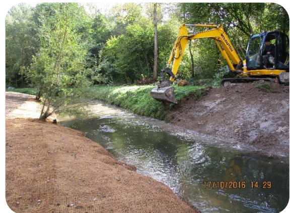
Talutage des berges et création de banquettes
