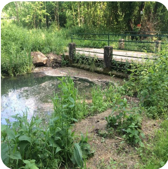
Pont du Clochard
