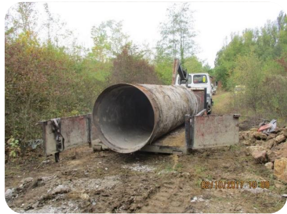
Retrait buses et évacuation de 100m 3 de gravats et des 4 buses (140 cm et 5000 kg)
