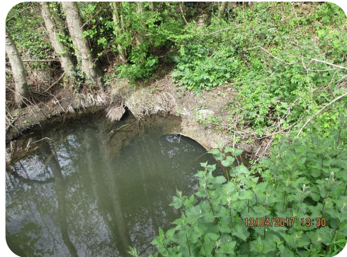
Avant travaux : 2 séries de busages mal calibré faisant obstacle à la continuité
