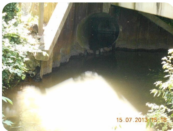
Rejet de collecteur rue des Pâtis
