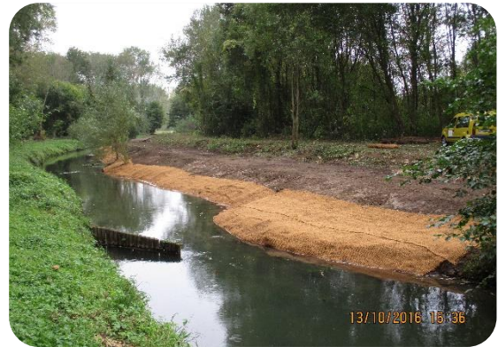
Création de banquettes et pose de géotextile
