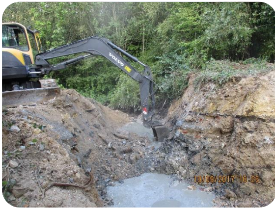
Retrait buses et évacuation de 100m 3 de gravats et des 4 buses (140 cm et 5000 kg)
