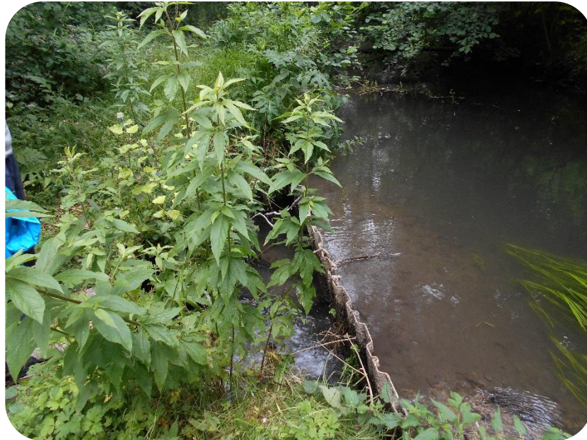
Fuite de la Viosne malgré les ouvrages artificiels de protection de berges
