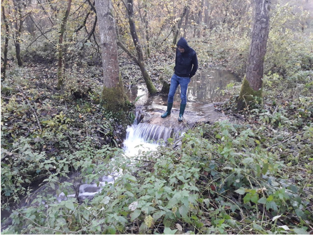
Retrait d'un seuil (bloc de grès) entravant la continuité écologique sur le ru de Moussy.
