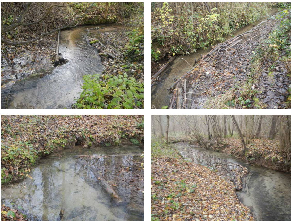
Figure 28 : Ouvrages de diversification des écoulements sur la Viosne à Lavilletterre
