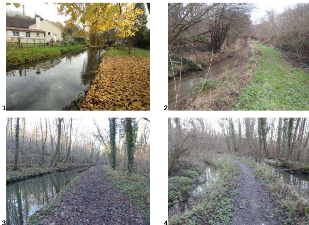
Figure 55 : Entretien drastique des berges (1) La Viosne à Santeuil – (2) La Coulevre à Santeuil – La Viosne en amont du moulin de Boissy – (4) La Viosne en amont du moulin Réal
