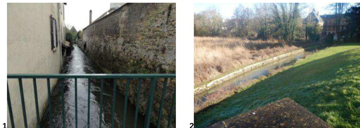
Figure 44 : Travaux de chenalisation sur la Viosne (1) Pontoise – (2) en amont du moulin de Courcelles-sur-Viosne
