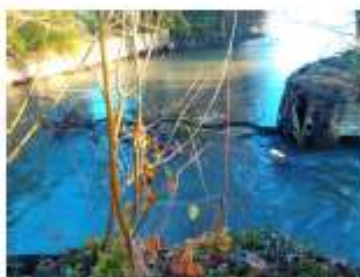
Ouvrage répartiteur : palplanches
