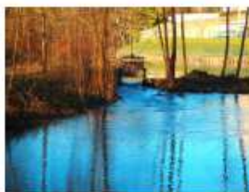
Vue aval de la vanne de l'étang
